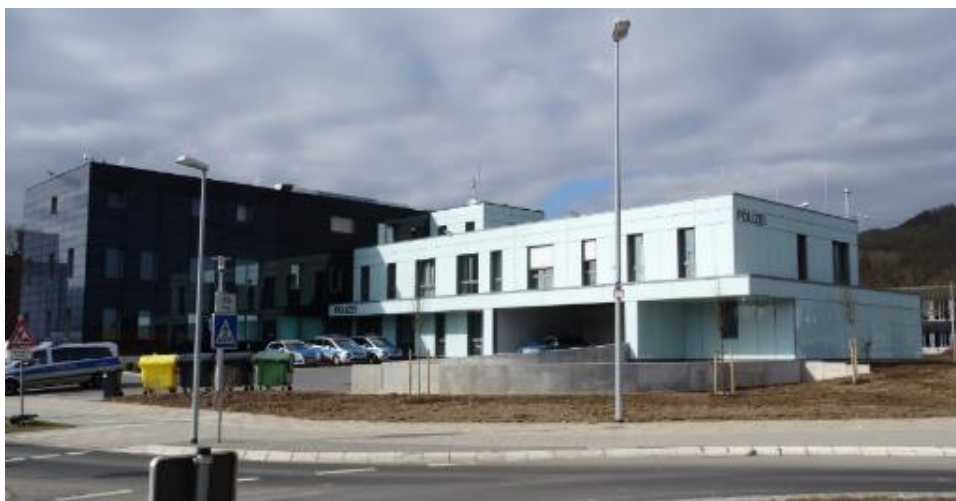
Abbildung 9: Polizeistation, Baunatal (Kombination BIPV – monolithisches ESG) (Quelle alsecco GmbH | Foto: Matthias Merz)
