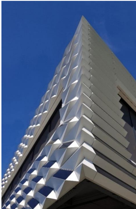
Abbildung 10/11: SOLAR.shell Photovoltaikfassaden am Bürotrakt der Aluform GmbH, Bad Rappenau. Ansicht der Westfassade und Eckausbildung Süd-West. Projektleitung: Architektur-Institut der HTWK Leipzig (ai:L), (Fotos Frank Hülsmeier)
